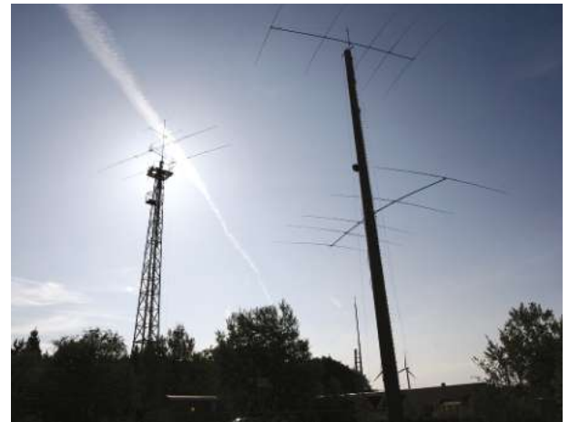
Gittermast links mit 2 El. 40 m Monobander und FB-33; Betonmast rechts mit 2 x 5 El. 20 m Monoband
