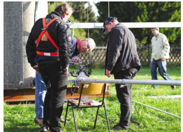
Startklar zur Mastbesteigung: Helmut, Klaus und Jürgen bei der Vorbereitung
