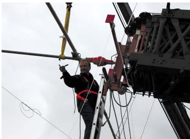
Bild 1: DF7ZS packte beim Aufbau der Antennen selbst an
